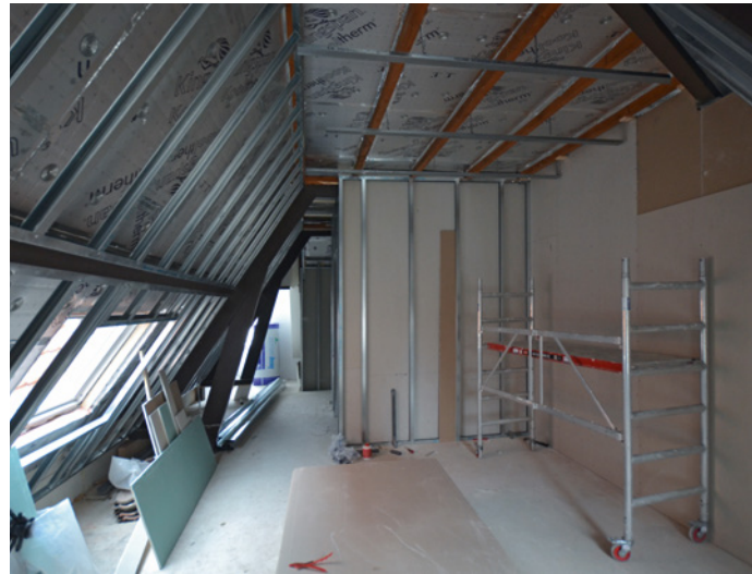
Geïsoleerde dakverdieping aan de Vrouwenregt Delft
